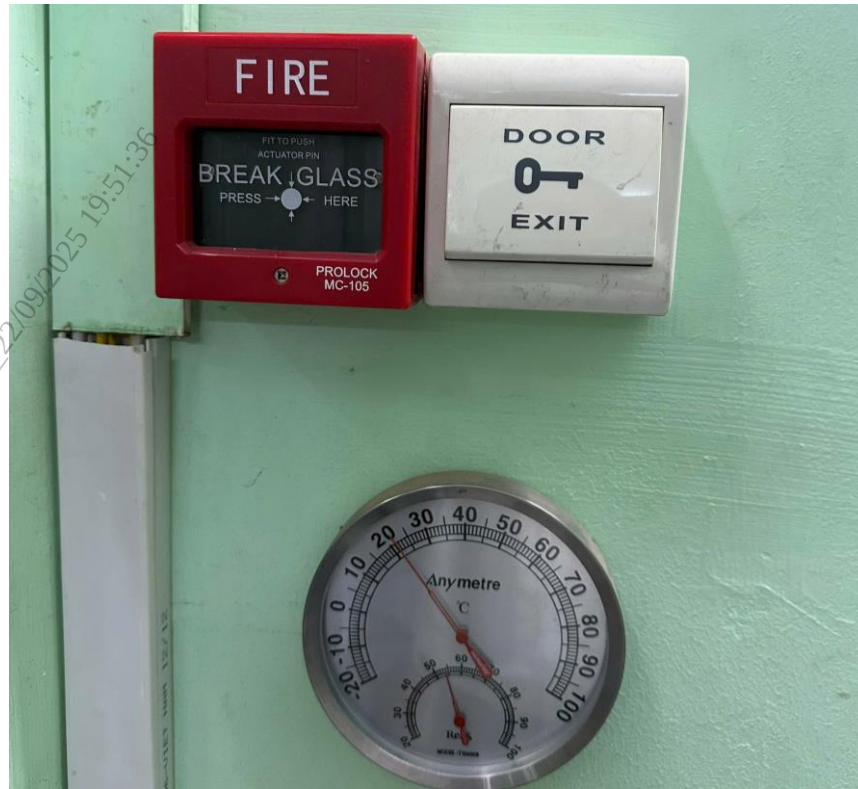
Thiết bị kiểm soát nhiệt độ, độ ẩm, báo cháy, kiểm soát ra vào
